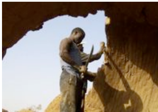
Chantiers VN au BF, 2009
