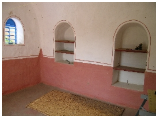
Enduit ciment peint sur murs et chape ciment
