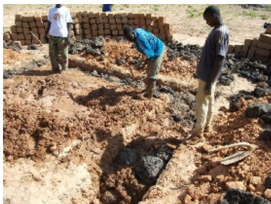
Mise en œuvre de fondations pierres + terre
