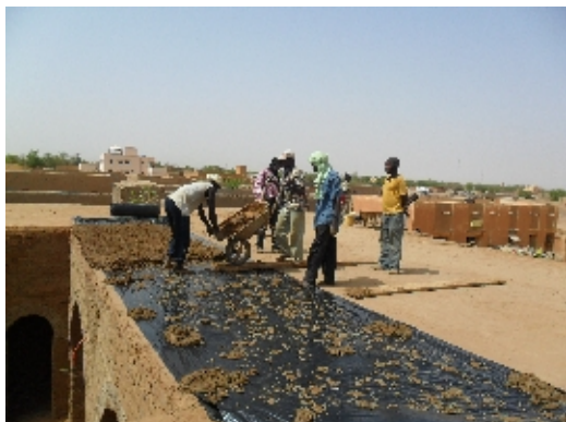
Pose de la bâche plastique
