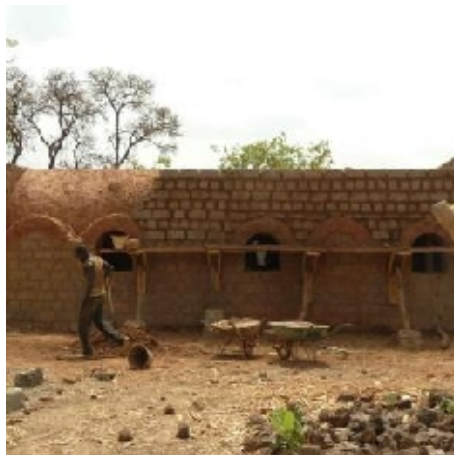
« Contreforts » en cours de mise en œuvre
