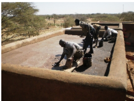
Enduit goudron en cour d'application
