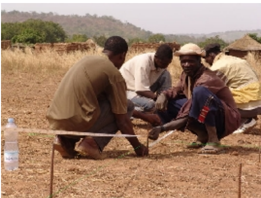
Implantation d'un bâtiment
