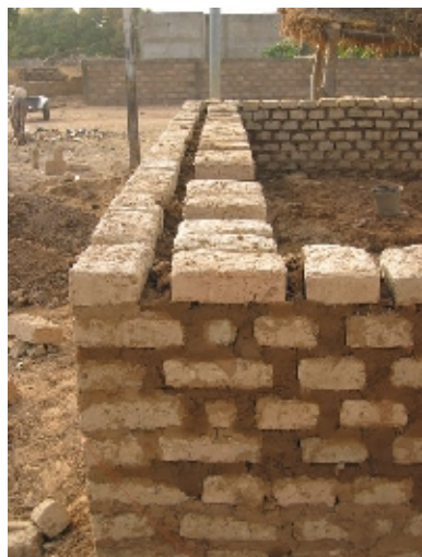
Mur porteur avec vue de l'alternance des rangs
