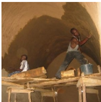
Enduit terre fine en cour de réalisation
