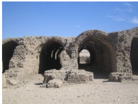
Voûtes du Ramesseum – Egypte ~ 1300 AV-JC
