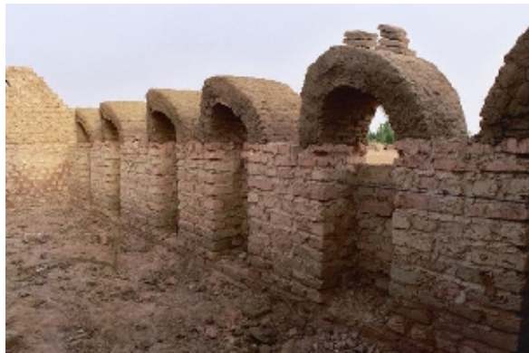
Voutains avec cloisons et réservation fenêtres
