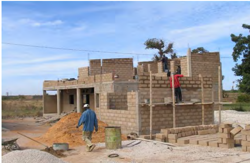
Photo12 : un chantier en construction à usage du ciment
