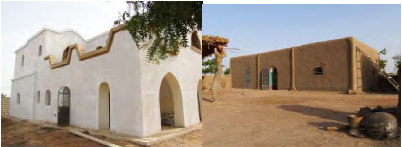
Photo9 : Réalisation de l'AVN à Thiès et à la zone de Tambacounda
