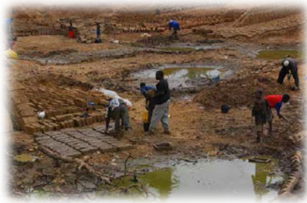
Photo 1: Fabrique de briquettes
